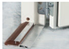
Handikappanpassad tröskel i utförande trä/aluminium, 25 mm hög.
